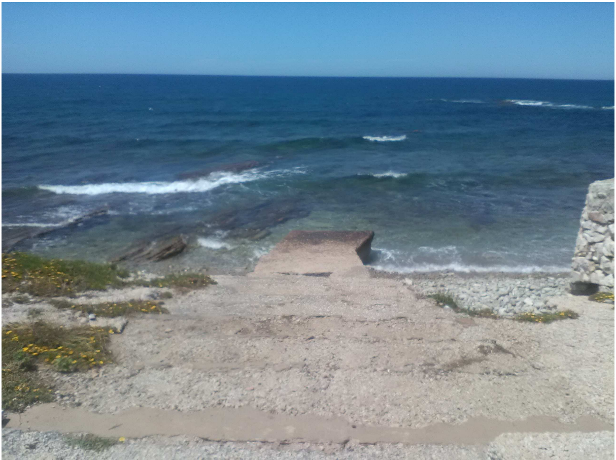
Foto 23.a – Manufatto in conglomerato cementizio costruito sull'arenile per raggiungere la battigia all'estremità verso mare di via Eurialo.
