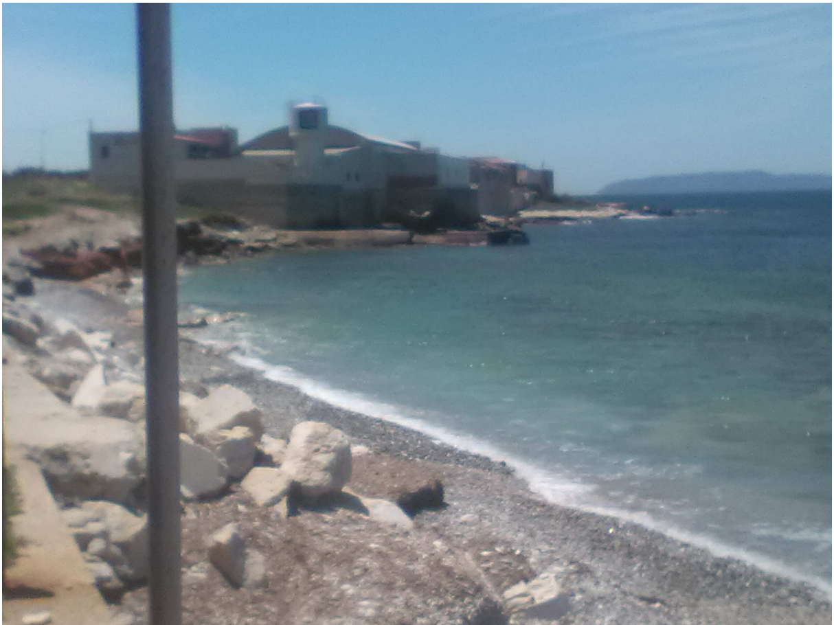
Foto 12 – Insedimento adibito ad attività produttive, principalmente segherie di marmo ora dismesse, sulla lingua di terra che si protende verso mare a Sud Ovest la baia in località Casa Calvino : vista da Nord-Est (dalla S.P. 20); si nota il pennello che protegge lo sbocco a mare di un collettore della rete urbana di drenaggio delle acque meteoriche
