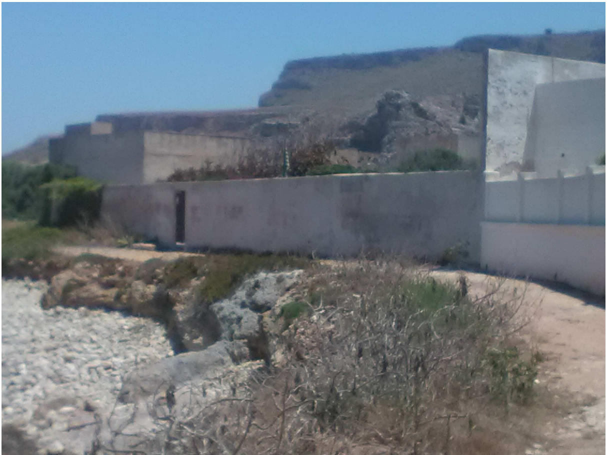
Foto 24.c – Tratto di spiaggia a Nord Est di via Cloanto: accesso alla spiaggia da via Cloanto.
